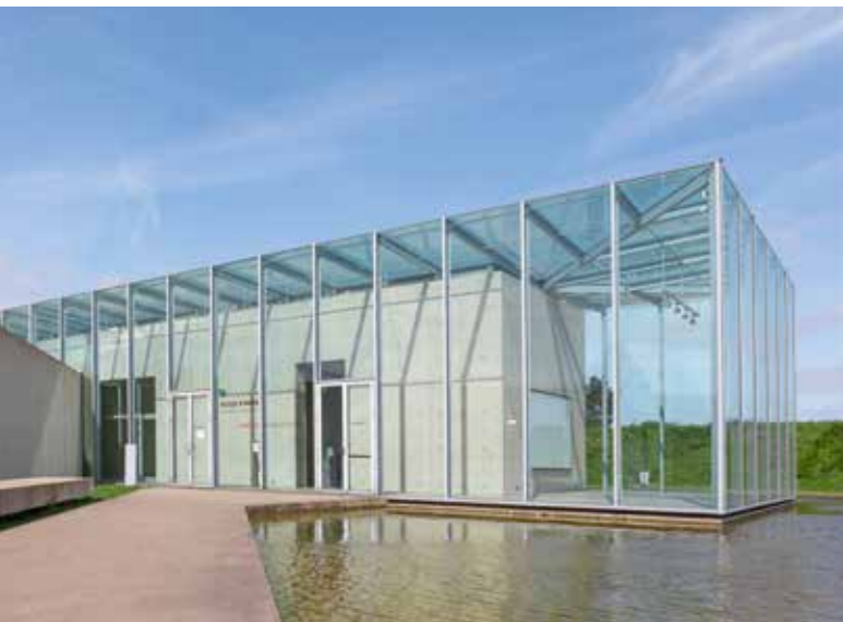
Stahl, Glas und Beton in der bäuerlichen Landschaft des Niederrheins: Der Bau von Tadao Andō
